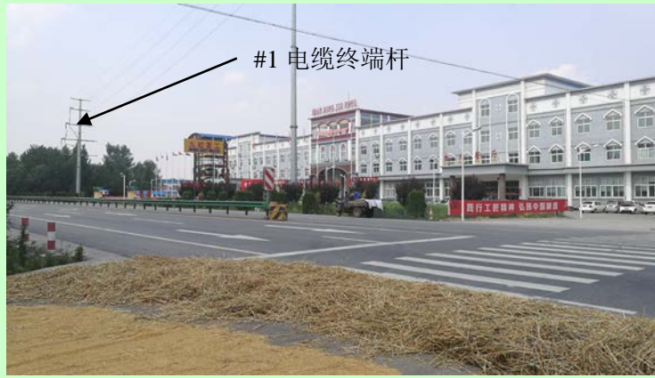
本次单侧挂线线路现状
