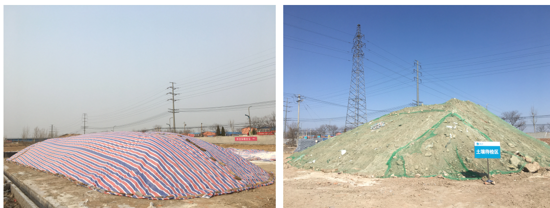
图 4-1 修复后土壤的堆存与覆盖
