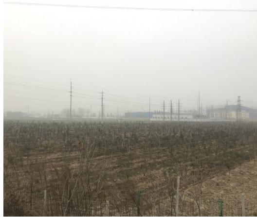
110kV 前仓站南侧
