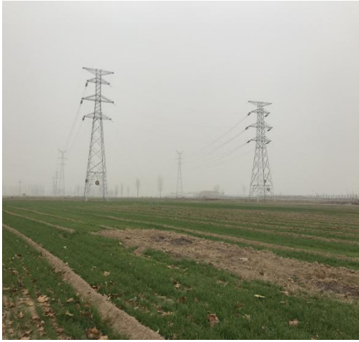
220kV 仙鹤站 110kV 电缆线路路径空地
