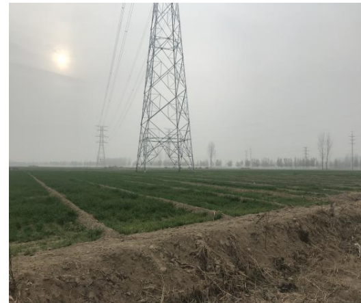
新建前仓-古云 \pi 入仙鹤 110kV 线路路径空地处
