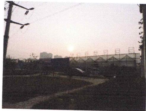
图片 1-2 变电站南侧
