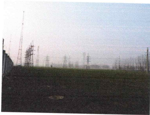
图片 1-4 变电站北侧
