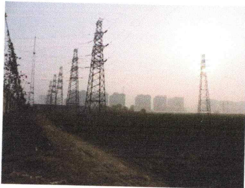
图片 1-3 变电站西侧
