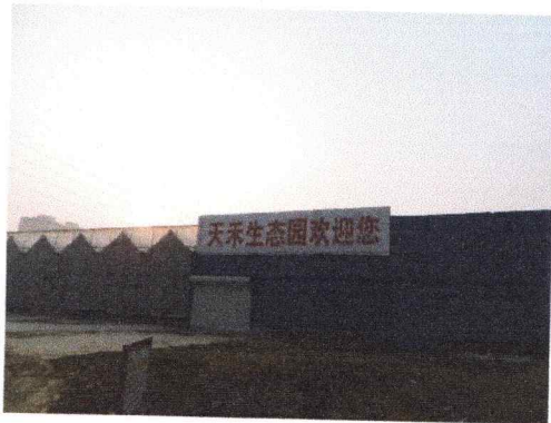
图片 1-5 变电站南侧 1m 处天禾生态园
