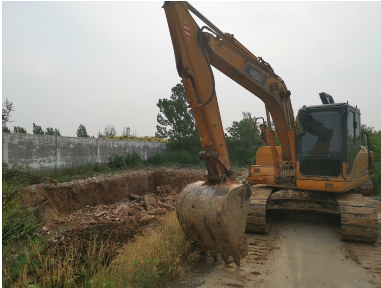
图 3.3-1 场地水池拆除
