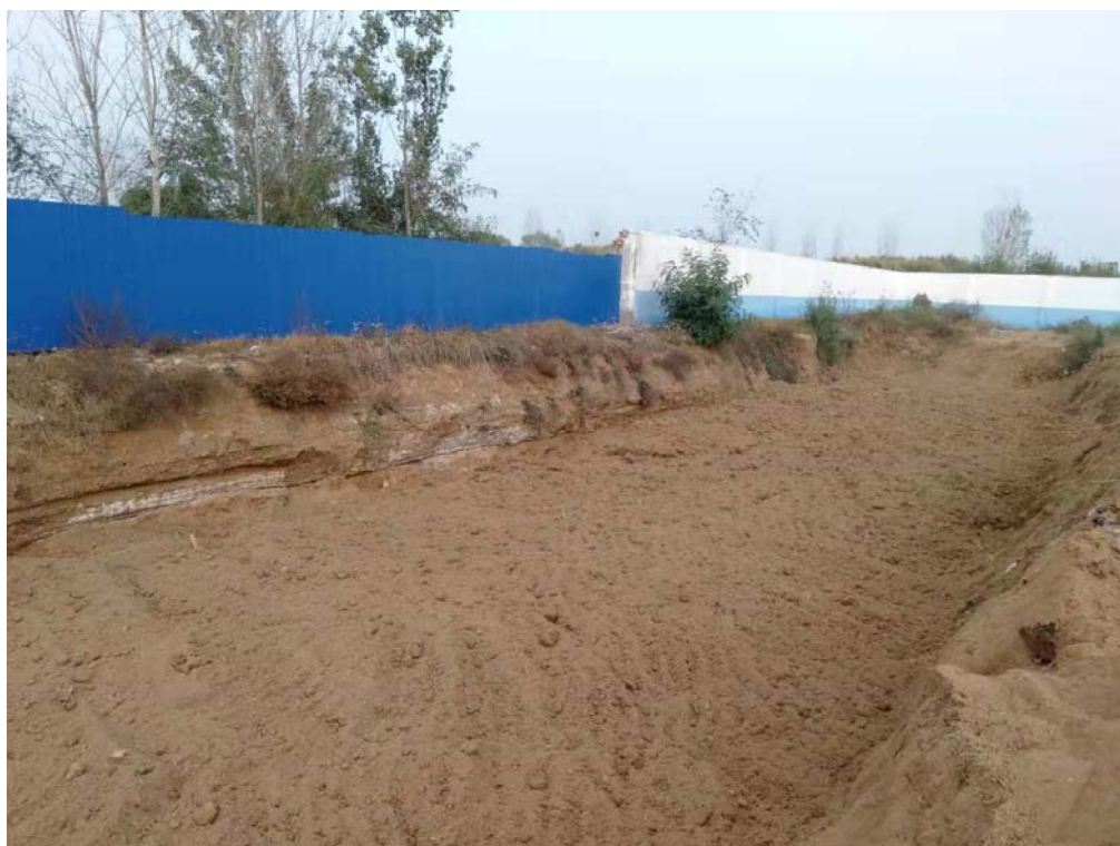
图 1-2 修复后现场情况
