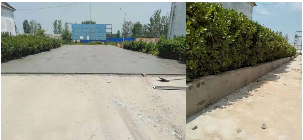
图 3.3-2 临时修复场地铺设
