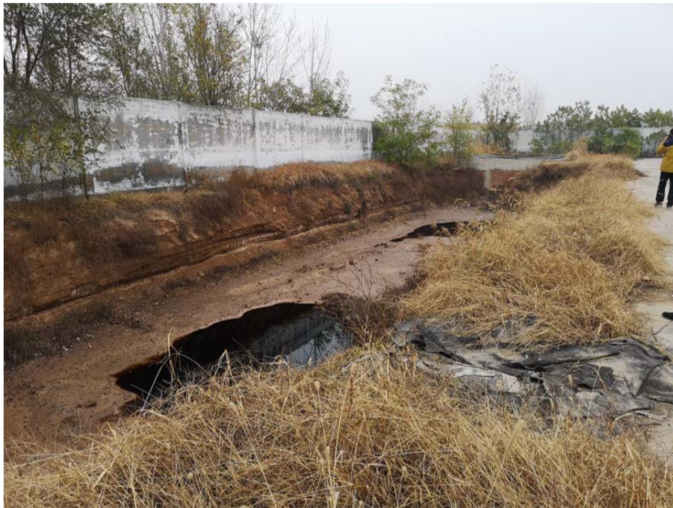
图 1-1 修复前现场情况
