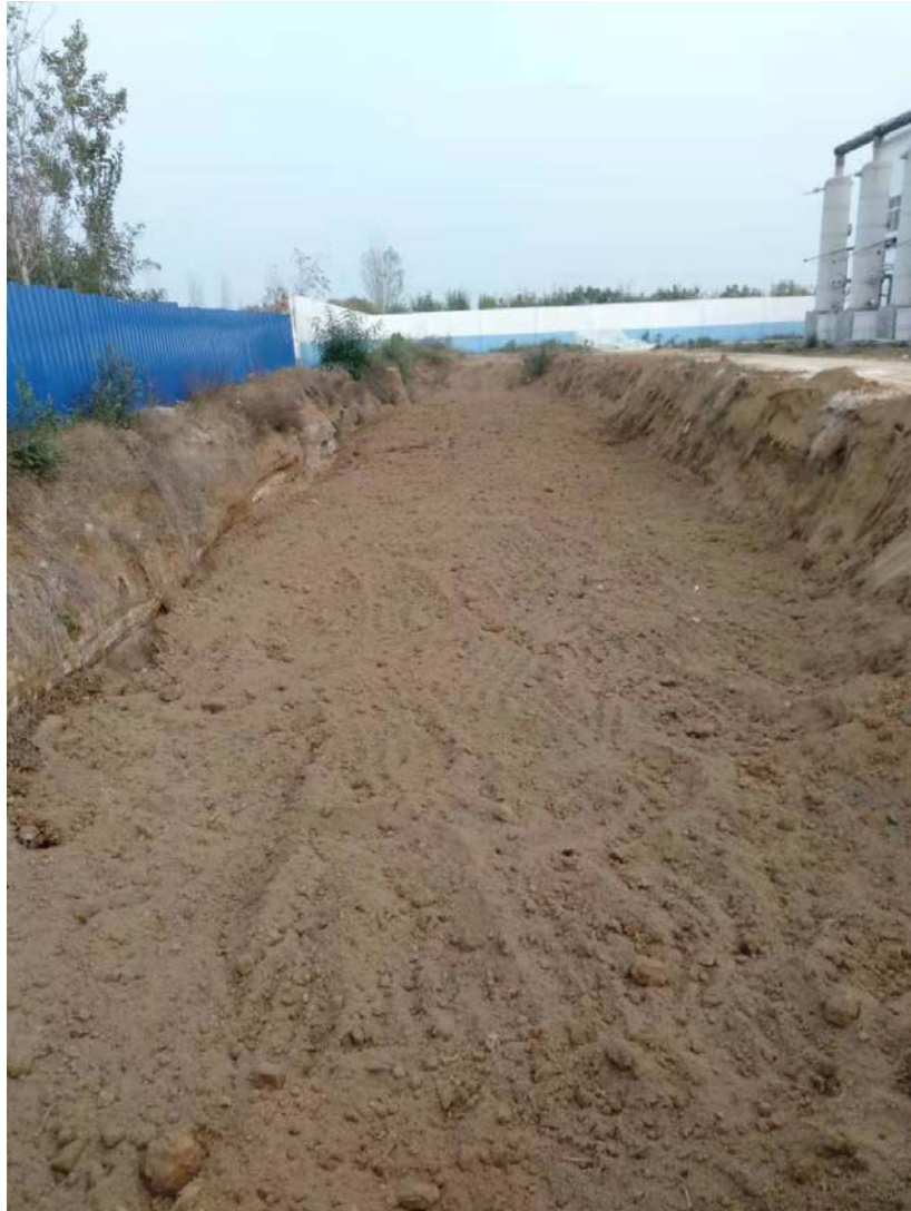
图 3.3-12 养护达标后回填
