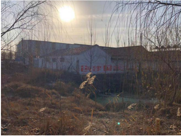
绣衣集村西北钢管厂厂房
