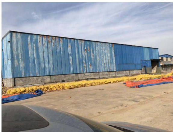
济聊一级路与位山干渠交叉处西北角粮食仓库 看护房（拆迁区）
