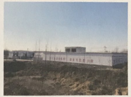
拟建线路东南 25m 省道 S333 西侧垃圾处理站
