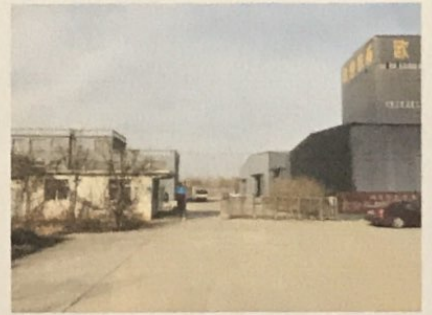
拟建线路北 26m 山东华中塑业有限公司门卫和厂房
