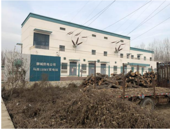
马西站大门及配电装置楼
