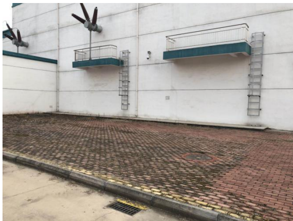
站址内本期 2#主变拟建位置
