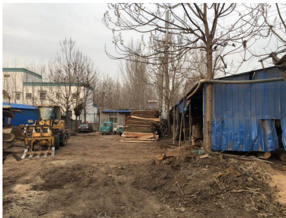
站址东侧的木板厂 2
