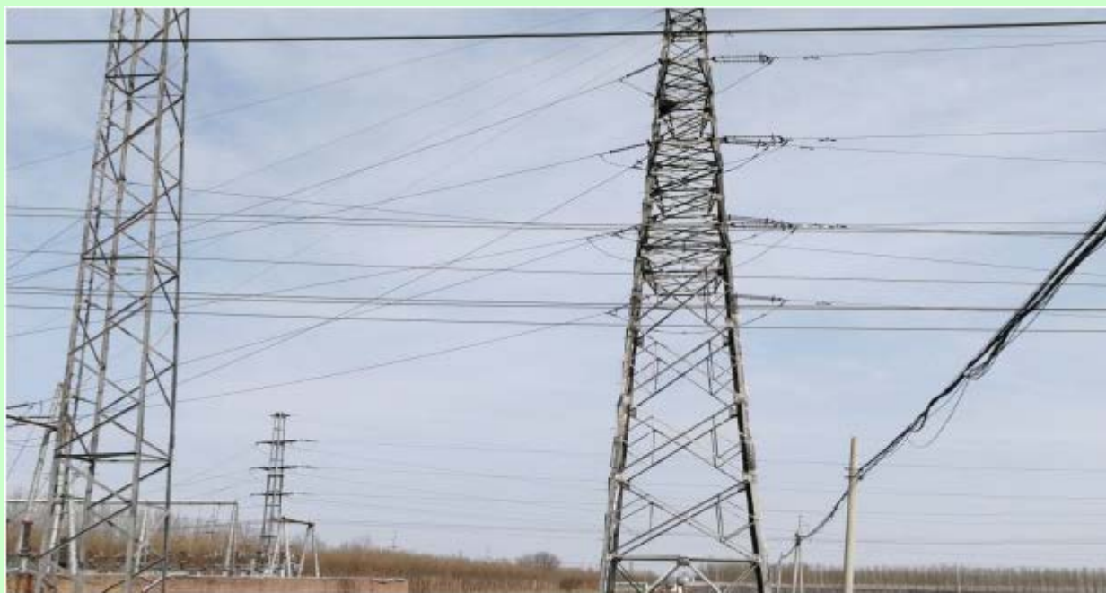
原南镇站双回进线终端塔现状
