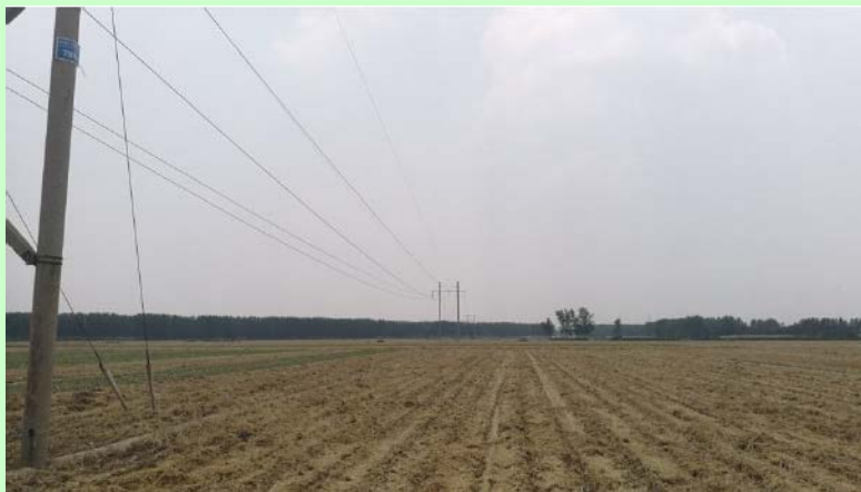
110kV 谭镇线 85#-14#杆塔现状
