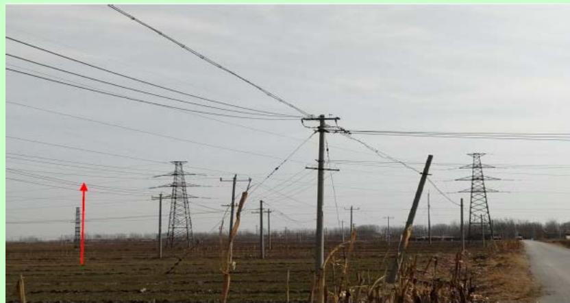
D2 位置组立终端塔现状
