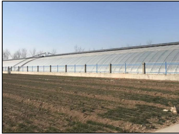
站址西侧待拆迁大棚
