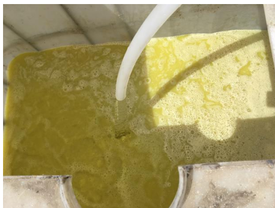
现场配置修复药剂
