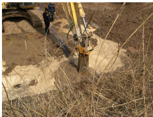
污染土壤边搅拌边加修复药剂
