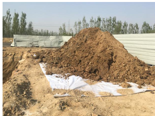
清挖污染区域 1 上部 2m 污染土壤
