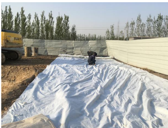
污染区域 1 南侧铺设复合土工布进行防渗
