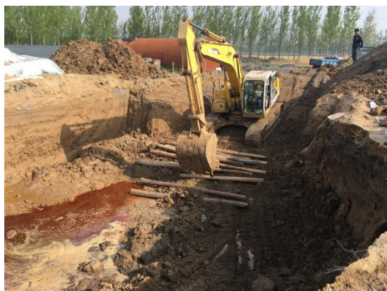
铺设斜坡搅拌下部 2.5m 污染土壤
