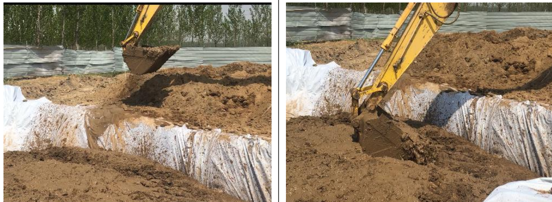
修复后土壤直接放至旁边堆存区
