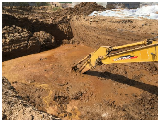
搅拌回填后上部 2m 污染土壤
