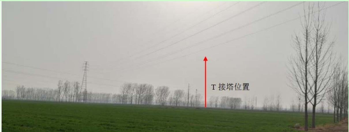
110kV 耿楼 I 线#6 塔
