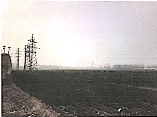
图片 1-3 变电站西侧
