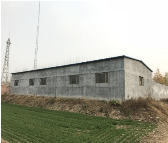
站址东南角南侧围墙相邻厂房
