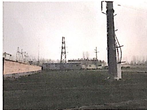
图片 1-2 变电站南侧
