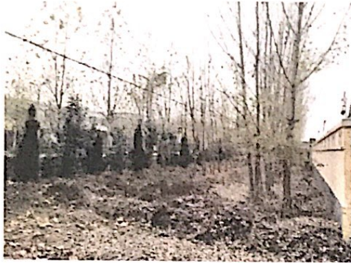
图片 1-1 变电站东侧
