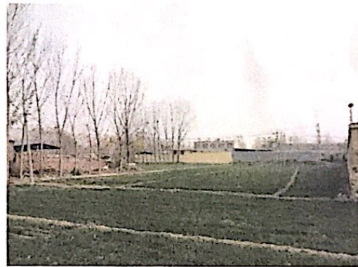
图片 1-4 变电站北侧
