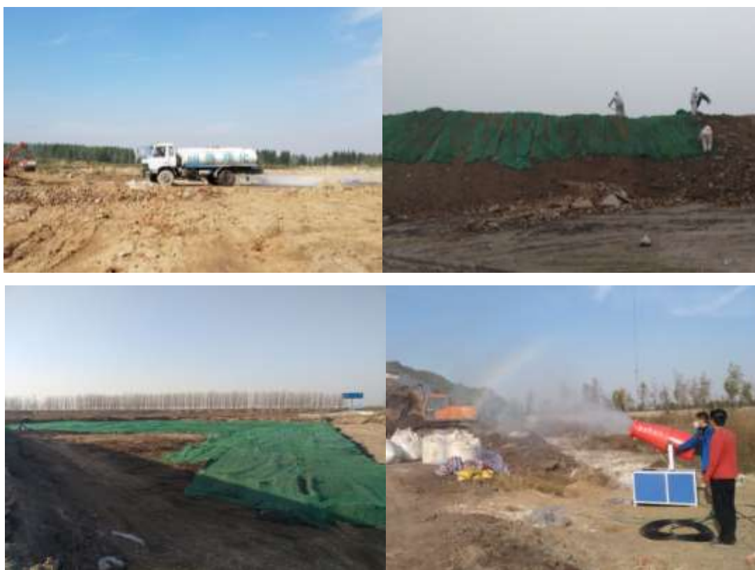
图 4-5 清挖修复施工降尘
