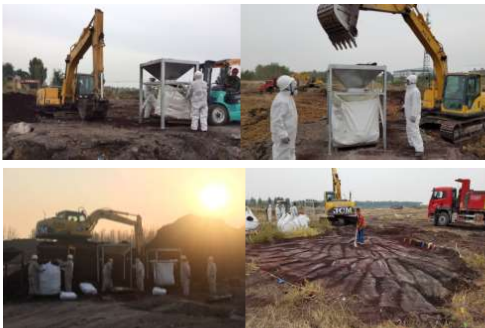
图 3-18 危险废物的清挖与封装
