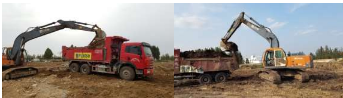
图 3-13 土壤清挖施工
