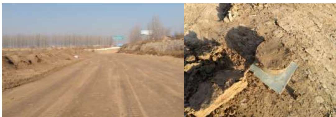
图 5-2 回填区分层压实及取样送检
