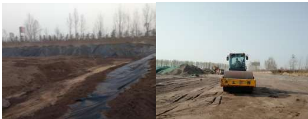
侧壁防渗膜铺设
