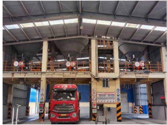
水泥散装通道
