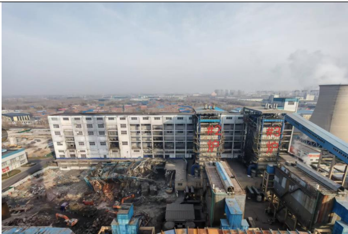
锅炉建设位置（2#锅炉西侧）
