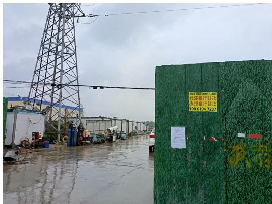
12 临时施工板房
