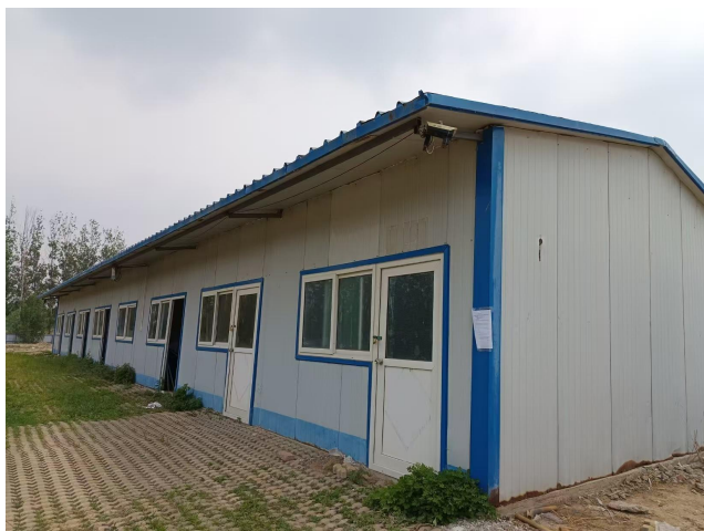
11 临时板房与闲置房屋
