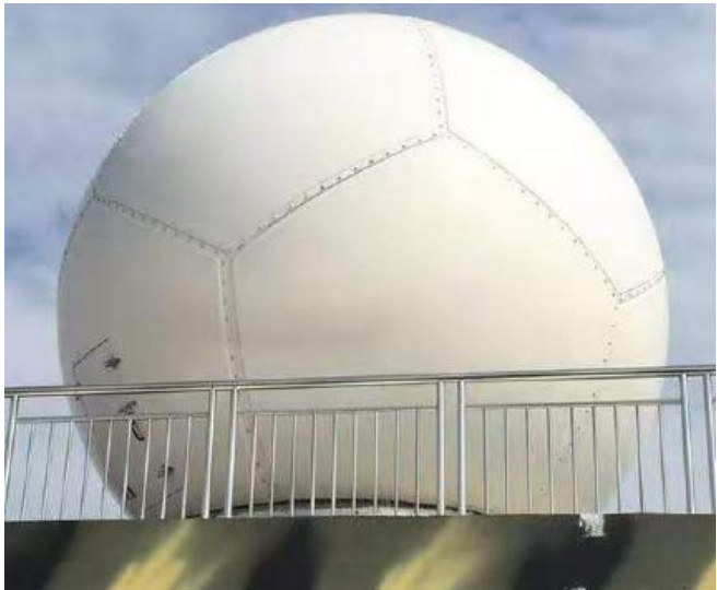
图 2-7 雷达天线罩示意图
