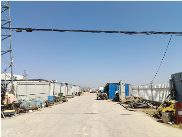
12 临时施工板房
