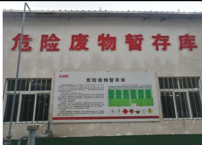
图 5.6-1 园区现有危废暂存库
